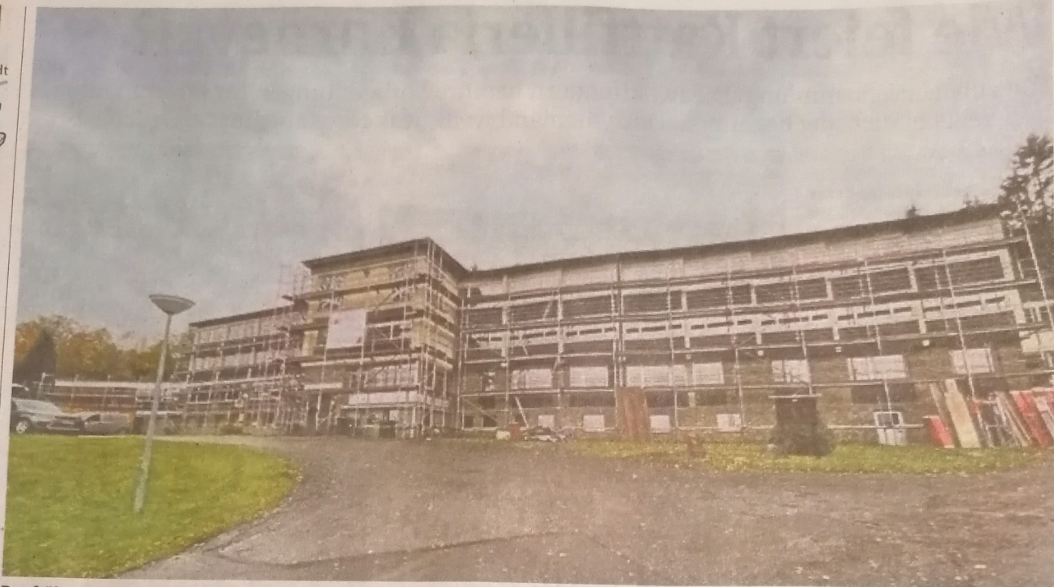
Das frühere Josef-Gockeln-Haus ist eingerüstet. Die Umbauarbeiten zu einer Fachklinik laufen seit einigen Wochen.
